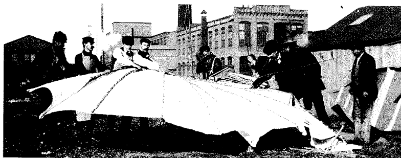
Einer von Weißkopfs Flugapparaten, der sogenannten „Nr. 21“ ähnlich, doch nicht das gleiche Modell, wird hier auf den Schaden hin untersucht, den er bei hartem Aufprall auf die Wasseroberfläche im „Black Rock Harbor“ genommen hat.
